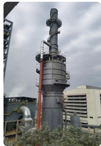
公司磁悬浮焙烧项目脱硫塔及除尘设备
