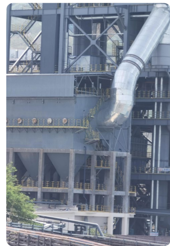
公司磁悬浮焙烧项目脱硫塔及除尘设备
